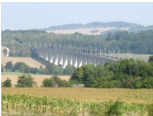
Abb. 44: Brücke der ICE-Trasse über Auetalniederung
