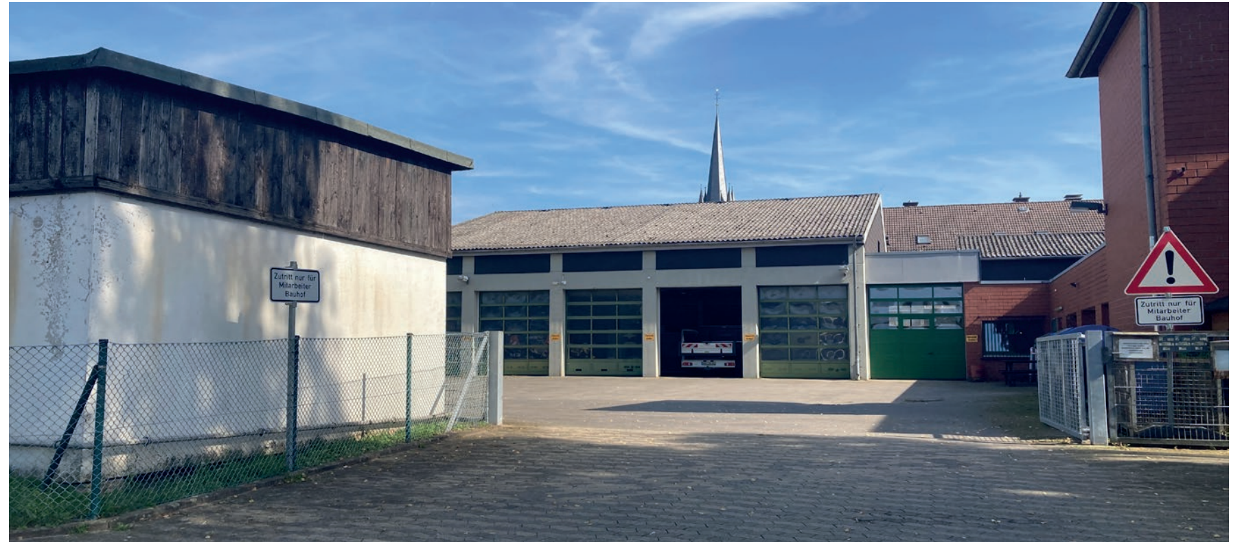
▼ Bauhof Nörten-Hardenberg, im Kniepestal
