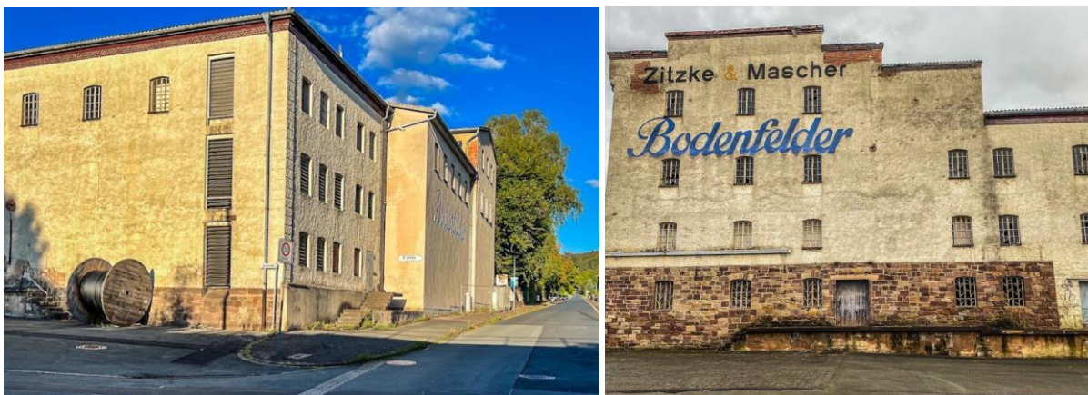
Abbildung 13: Ansicht Bestandsgebäude Alte Käserei 16
