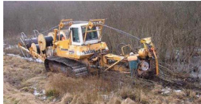
Kabellegeflug in Raupenausführung mit Vibrationstechnik (Bild: Fa. Lancier)
