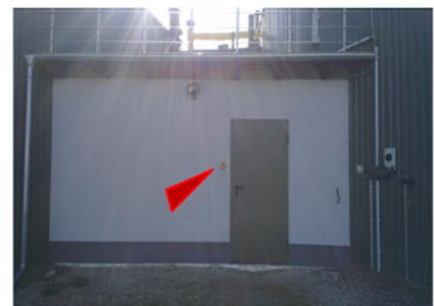
A: Eingang zum Pumpenraum / Not-Aus-Schalter
